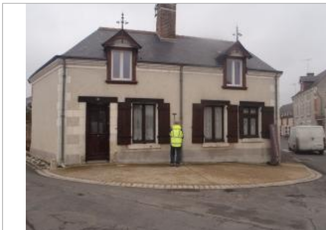
Vue du site (source : CEREMA, 2018)
