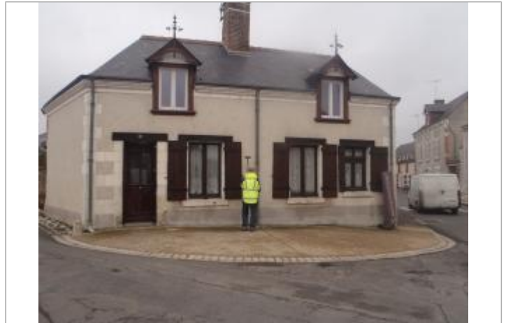
Vue du site (source : CEREMA, 2018)
