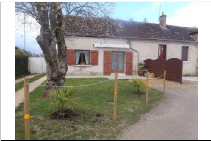
Vue du site (source : CEREMA, 2018)
