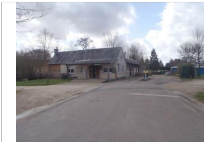
Vue du site (source : CEREMA, 2018)
