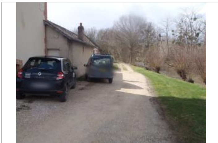
Vue du site (source : CEREMA, 2018)
