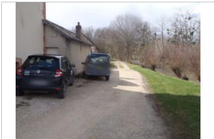
Vue du site (source : CEREMA, 2018)
