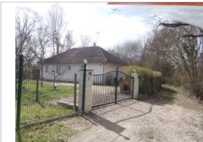
Vue du site (source : CEREMA, 2018)
