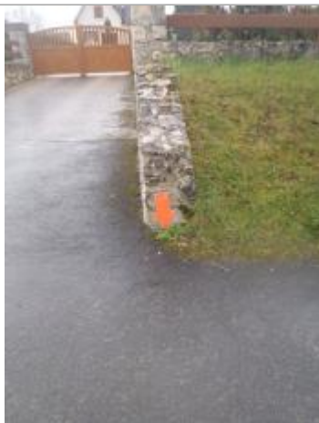
Vue du repère (source : CEREMA, 2018)
