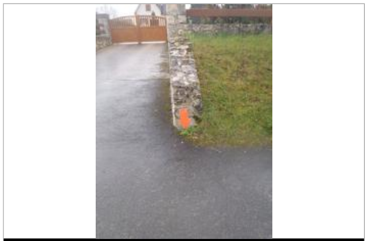
Vue du repère (source : CEREMA, 2018)
