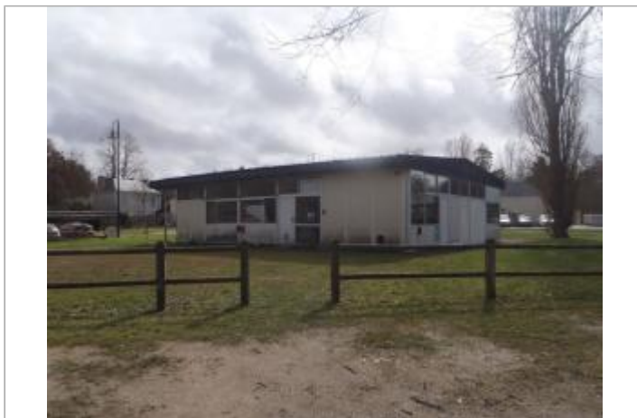
Vue du site (source : CEREMA, 2018)
