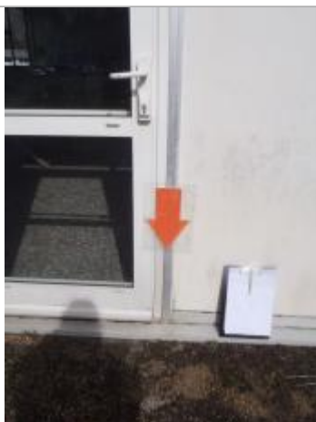
Vue du repère (source : CEREMA, 2018)
