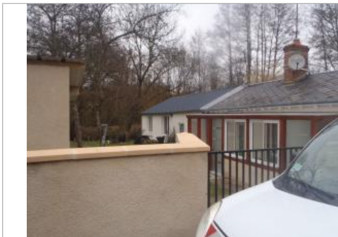
Vue du site (source : CEREMA, 2018)
