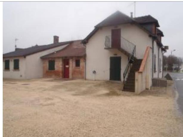
Vue du site (source : CEREMA, 2018)
