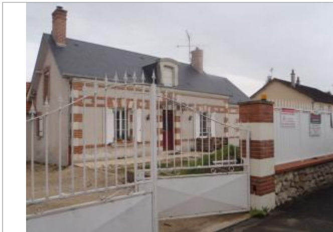
Vue du site (source : CEREMA, 2018)
