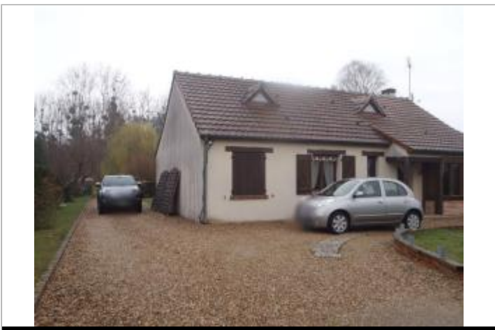
Vue du site (source : CEREMA, 2018)
