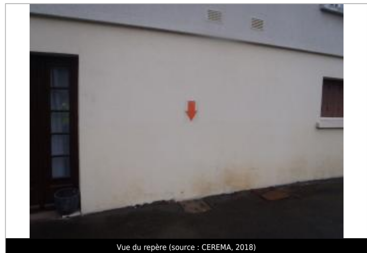
Vue du repère (source : CEREMA, 2018)
