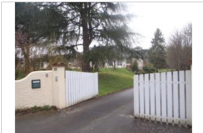
Vue du site (source : CEREMA, 2018)
