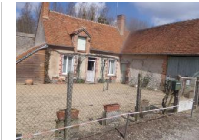
Vue du site (source : CEREMA, 2018)
