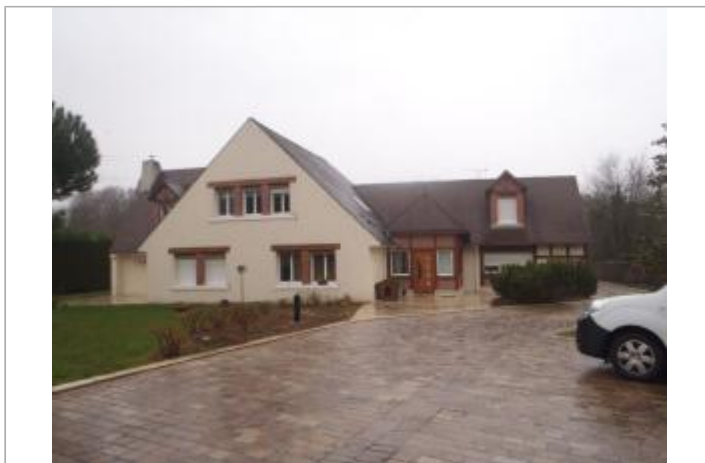
Vue du site (source : CEREMA, 2018)
