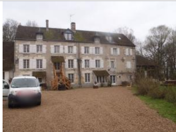
Vue du site (source : CEREMA, 2018)
