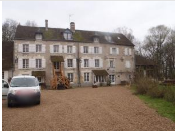
Vue du site (source : CEREMA, 2018)
