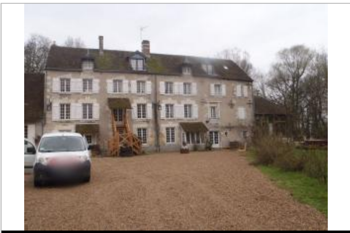
Vue du site (source : CEREMA, 2018)
