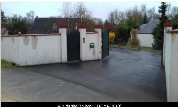
Vue du site (source : CEREMA, 2018)
