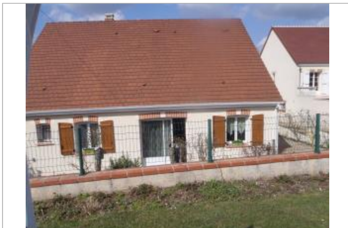
Vue du site (source : CEREMA, 2018)
