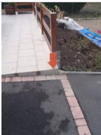
Vue du repère (source : CEREMA, 2018)
