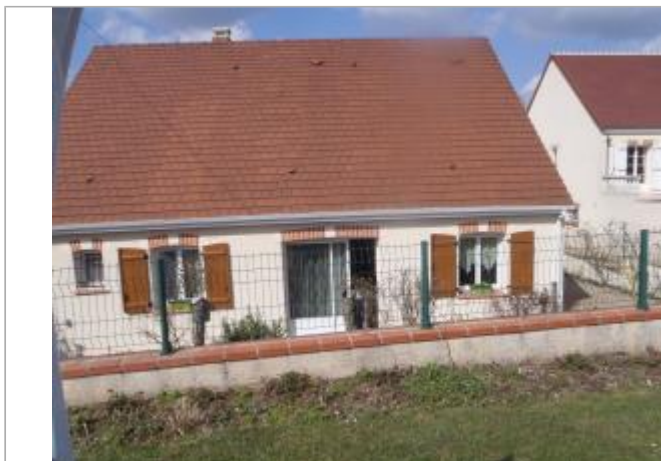
Vue du site (source : CEREMA, 2018)
