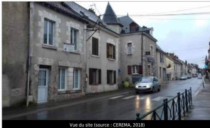
Vue du site (source : CEREMA, 2018)
