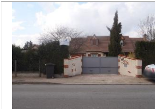
Vue du site (source : CEREMA, 2018)
