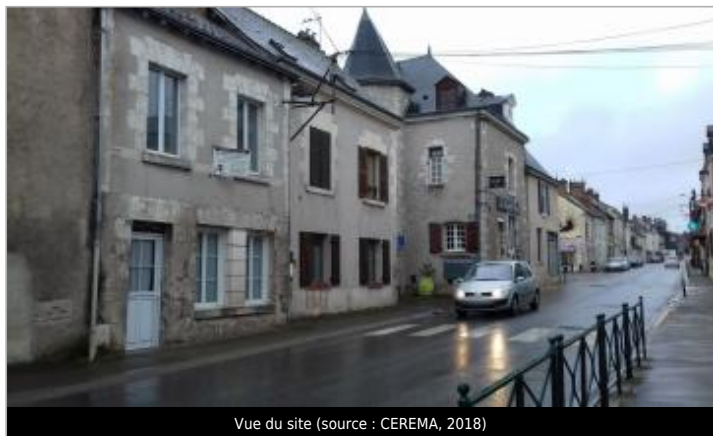
Vue du site (source : CEREMA, 2018)
