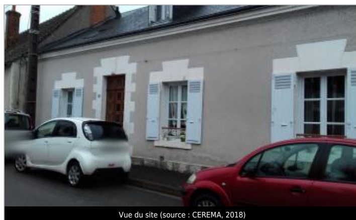
Vue du site (source : CEREMA, 2018)
