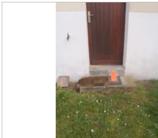
Vue du repère (source : CEREMA, 2018)
