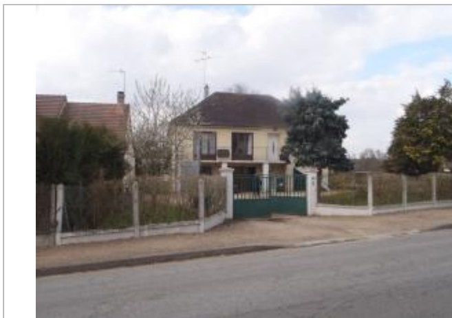
Vue du site (source : CEREMA, 2018)
