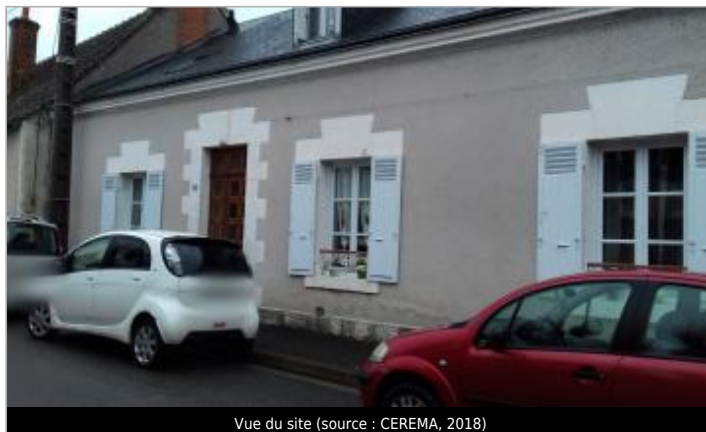
Vue du site (source : CEREMA, 2018)
