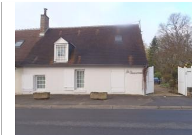
Vue du site (source : CEREMA, 2018)
