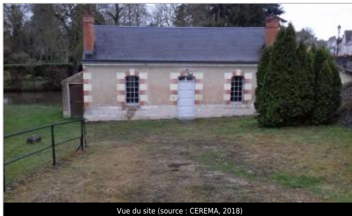
Vue du site (source : CEREMA, 2018)
