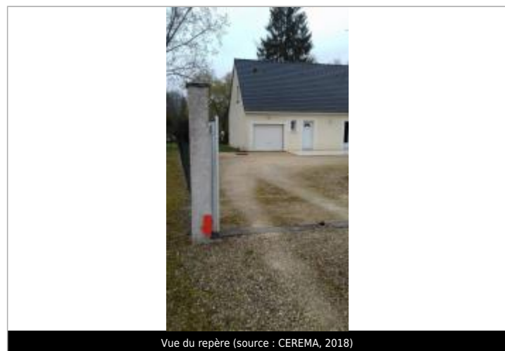
Vue du repère (source : CEREMA, 2018)
