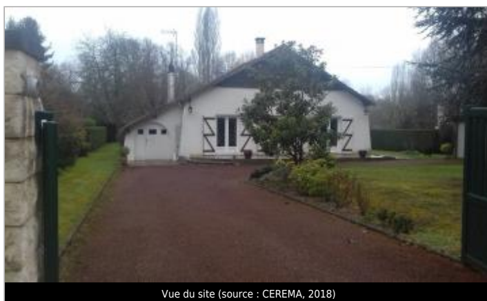
Vue du site (source : CEREMA, 2018)
