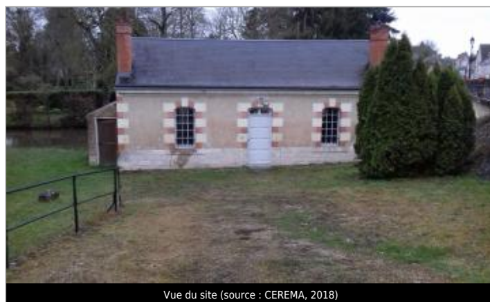
Vue du site (source : CEREMA, 2018)
