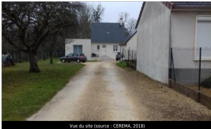
Vue du site (source : CEREMA, 2018)
