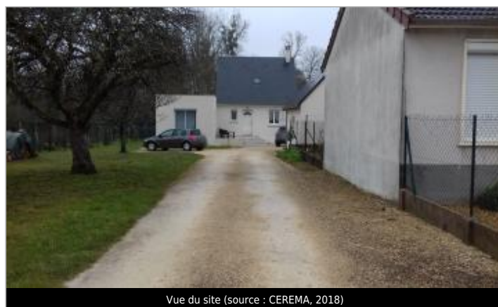
Vue du site (source : CEREMA, 2018)
