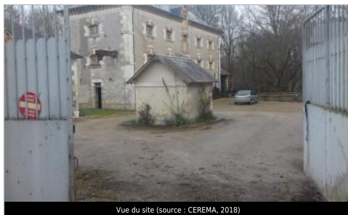
Vue du site (source : CEREMA, 2018)
