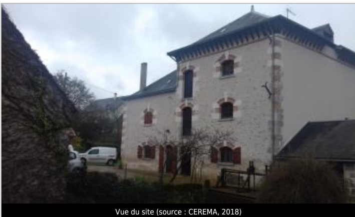
Vue du site (source : CEREMA, 2018)
