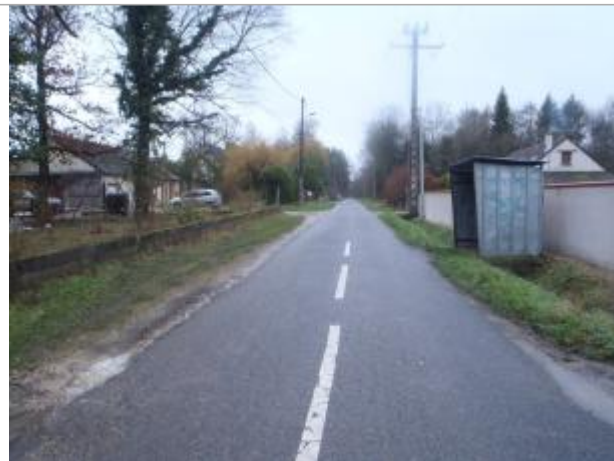
Vue du site (source : CEREMA, 2018)
