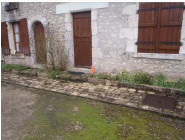
Vue du repère (source : CEREMA, 2018)
