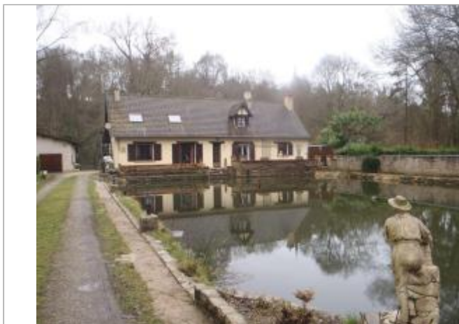
Vue du site (source : CEREMA, 2018)
