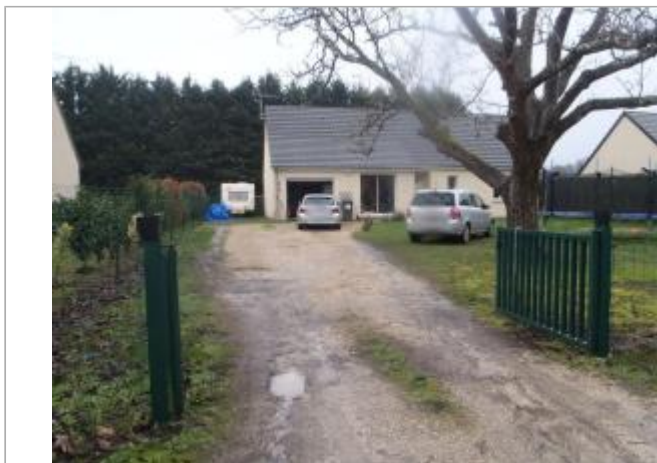
Vue du site (source : CEREMA, 2018)
