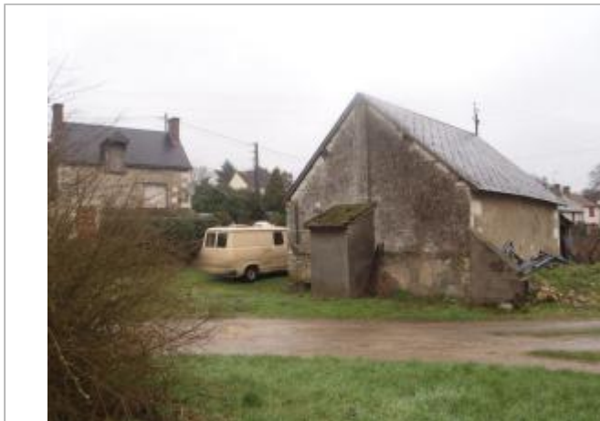
Vue du site (source : CEREMA, 2018)
