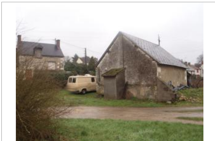
Vue du site (source : CEREMA, 2018)
