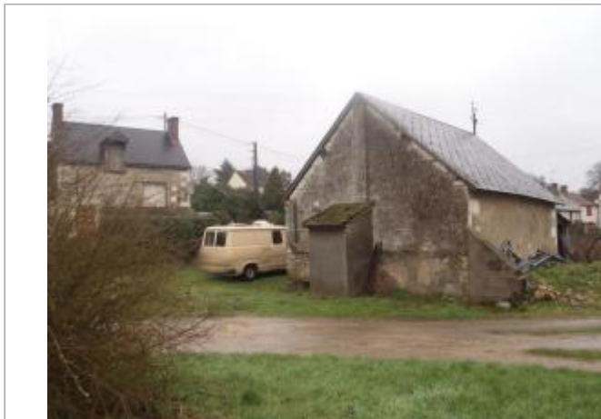
Vue du site (source : CEREMA, 2018)
