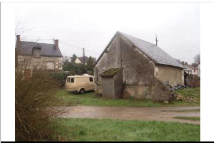
Vue du site (source : CEREMA, 2018)
