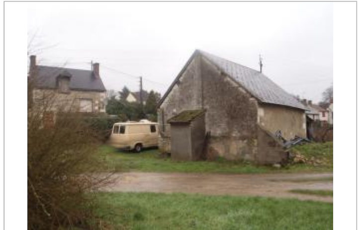
Vue du site (source : CEREMA, 2018)
