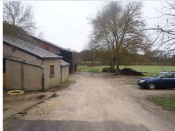
Vue du site (source : CEREMA, 2018)
