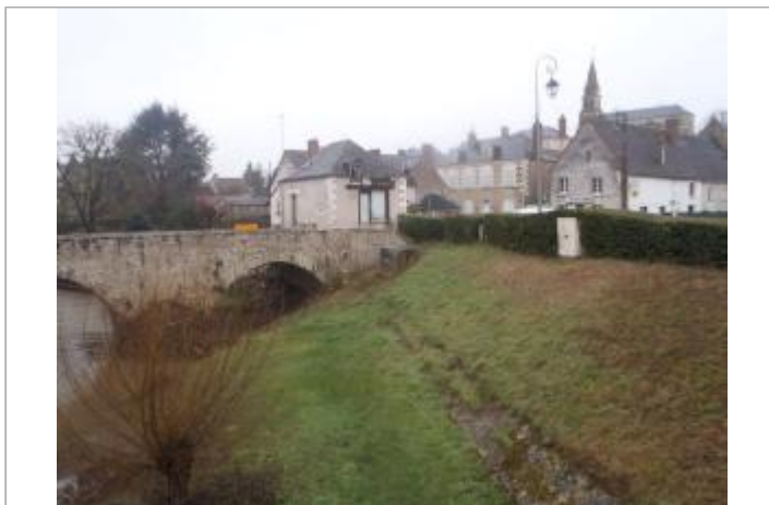
Vue du site (source : CEREMA, 2018)
