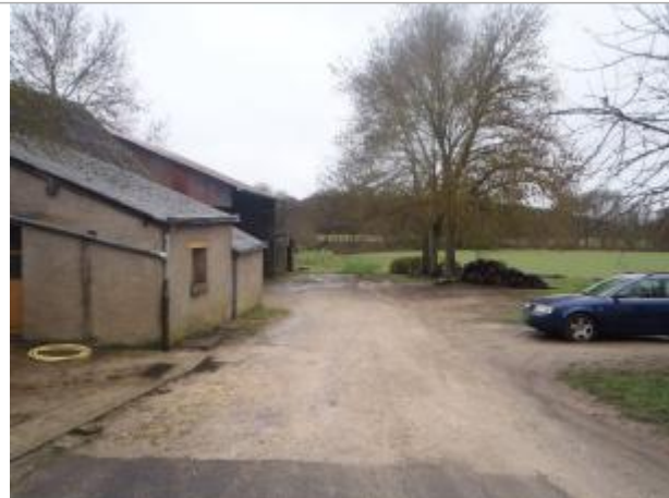
Vue du site (source : CEREMA, 2018)
