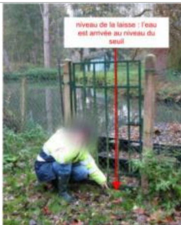
Repère en 2008 (source : CEREMA)
