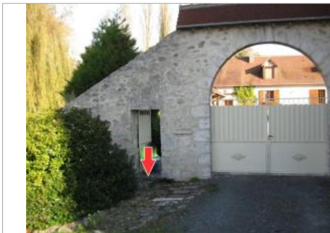
Site et repère de 2001 (source : CEREMA, 2008)
