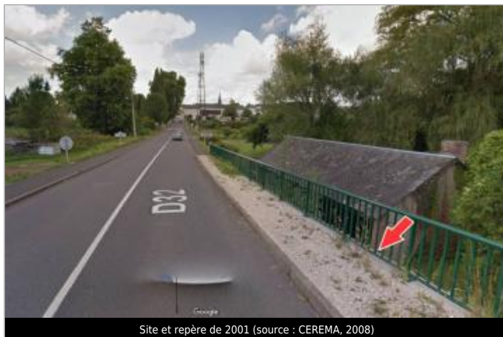
Site et repère de 2001 (source : CEREMA, 2008)
