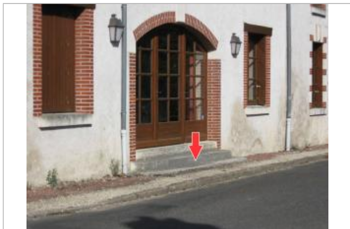
Repère de 2001 (source : CEREMA, 2008)
