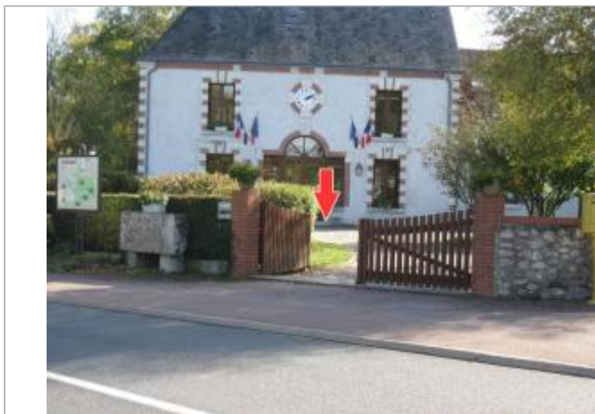
Site en 2008 et repère de la crue de 2001 (source : CEREMA)
