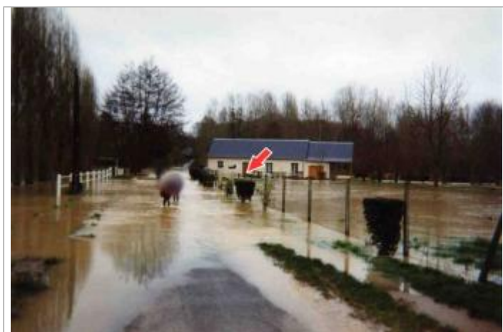
Site pendant la crue de 2001 (source : CEREMA)
