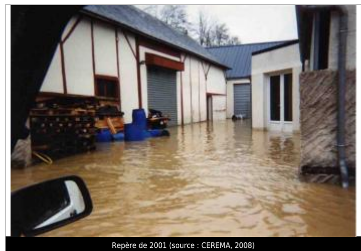
Repère de 2001 (source : CEREMA, 2008)
