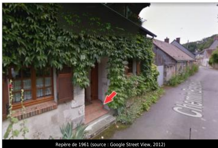
Repère de 1961 (source : Google Street View, 2012)
