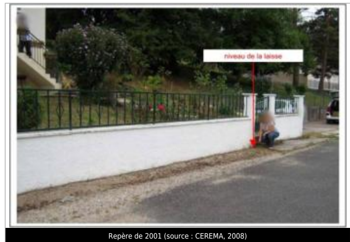
Repère de 2001 (source : CEREMA, 2008)
